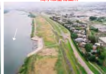
木曽川左岸19.6k付近
