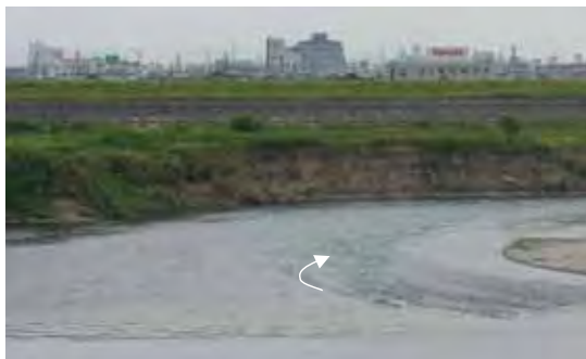
洗堀箇所 長良川左岸42.6k付近
