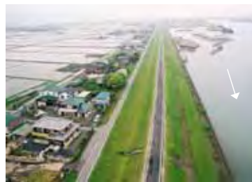
揖斐川右岸14.2k付近
