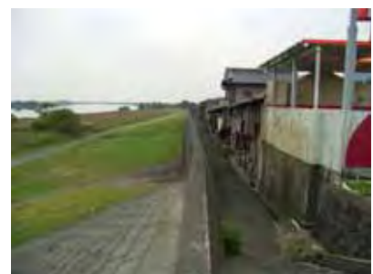
揖斐川右岸19.4k付近
