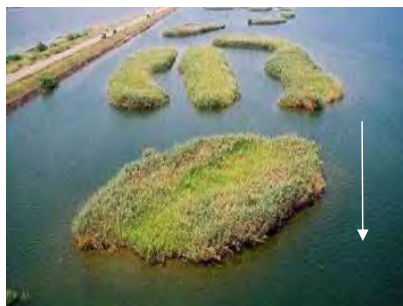
浚渫土を用いたヨシ原の造成 (長良川6km付近右岸)
