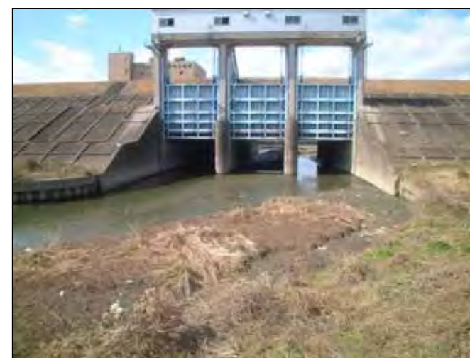
樋管吐出口に溜まった土砂撤去 (長良川右岸47k：両満川排水樋管)
