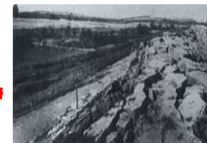
濃尾地震による長良川鉄橋 (東海道本線)と堤防の被害状況
