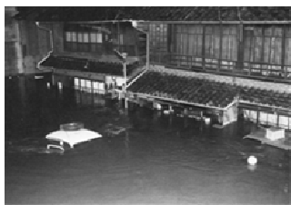
S58.9 木曾川における被災状況
