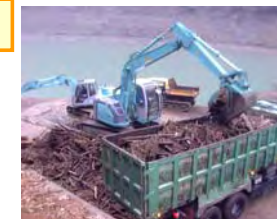
流木・ゴミの積込(横山ダム)
