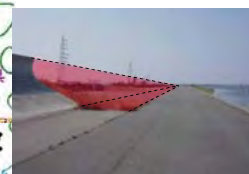
高潮堤防未施工箇所
