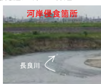
長良川左岸42.6k付近
