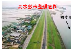
揖斐川右岸14.2k付近
