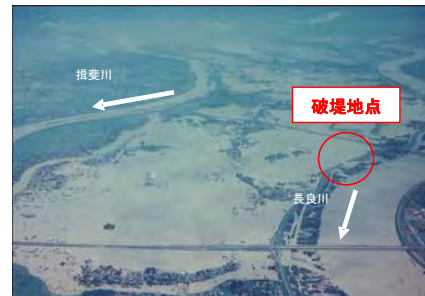
昭和51年9月洪水 (安八町の破堤氾濫状況)
