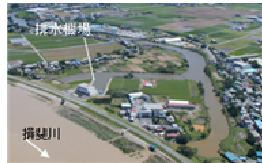
H14.7洪水における排水状況 (福東排水機場)
