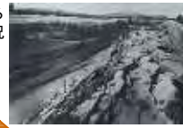
濃尾地震による堤防の被害状況
