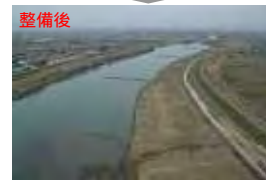
河道掘削（揖斐川 37.0k付近）
