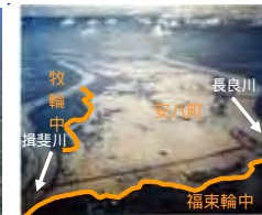
S51.9洪水の状況 輪中堤の機能
