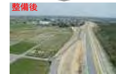
築堤（杭瀬川 5.6k付近）
