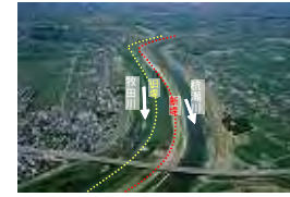
引堤（牧田川・杭瀬川背割堤）
