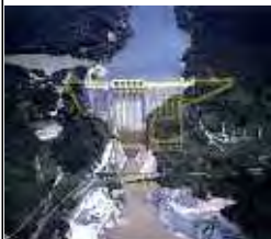
新丸山ダム（建設中） 《木曾川》
