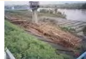
揖斐川流木の状況(34.6km左岸付近)
