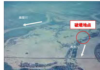
昭和51年9月洪水 (安八町の破堤区氾濫状況)
