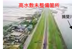
揖斐川右岸14.2k付近
