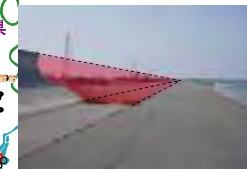
高潮堤防未施工箇所
