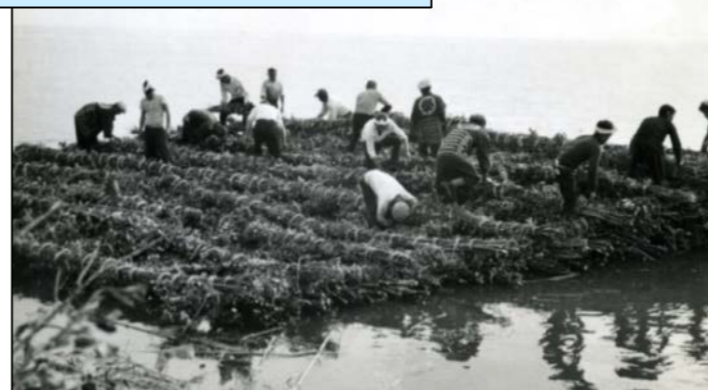
粗朶沈床を組み上げ
