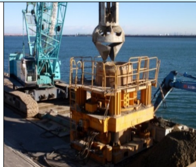
ハンマグラブによる支障物除去
