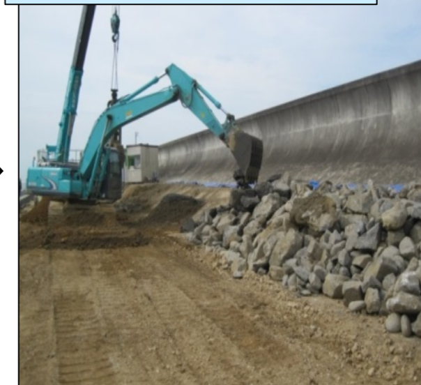
撤去された支障物(巨石)
