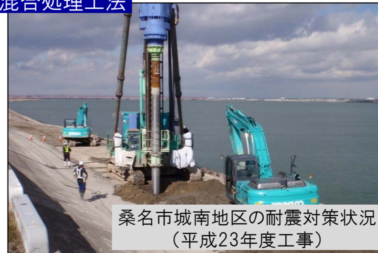
【対策工法(例)】 深層混合処理工法
