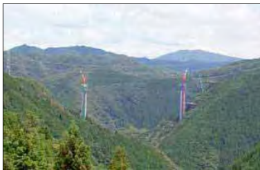
新旅足橋下部工完成 (H19. 2)
