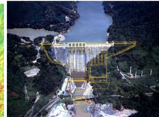
新丸山ダム（建設中） 【木曽川】
