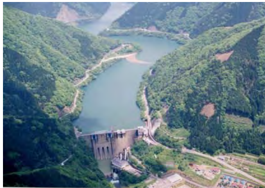
横山ダム（再開発中） 【揖斐川】
