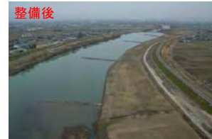
河道掘削(揖斐川 37.0k付近)
