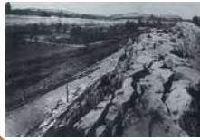
濃尾地震による堤防の被害状況
