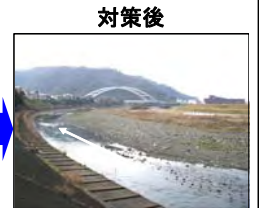
対策後 樹木伐開及び表土はぎ取りにより再生された砂礫河原
