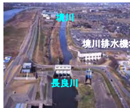
境川排水機場
