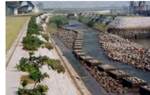
移動能力の低い生物にも対応した魚道整備事例 (せせらぎ魚道)
