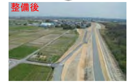
築堤(杭瀬川 5.6k付近)
