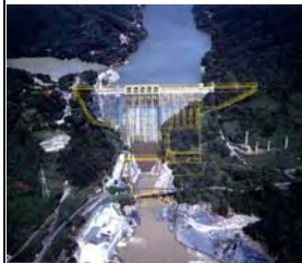
新丸山ダム（建設中） 《木曾川》
