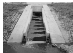
樋管の魚道改造事例
