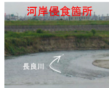
長良川左岸42.6k付近
