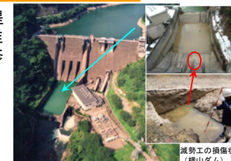
減勢工の整備状況 (横山ダム)
