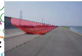
高潮堤防未施工箇所
