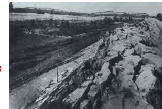
濃尾地震による長良川鉄橋（東海道本線）と堤防の被害状況 出典：「1891年の日本の大地震」（岐阜県歴史資料館蔵）
