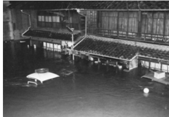
S58.9 木曾川における被災状況
