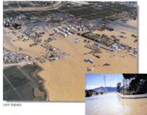
H14.7 揖斐川支川の被災状況
