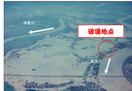
昭和51年9月洪水 (安八町の破壊氾濫状況)
