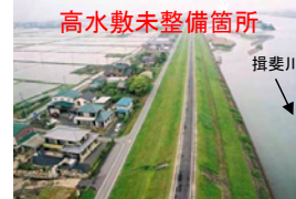
揖斐川右岸14.2k付近
