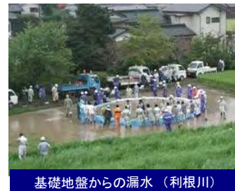
※利根川の写真は、国土交通省 河川局HPより
