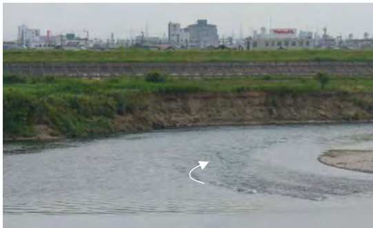
洗堀箇所 長良川左岸42.6k付近
