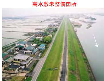
揖斐川右岸14.2k付近
