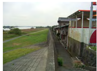
揖斐川右岸19.4k付近
