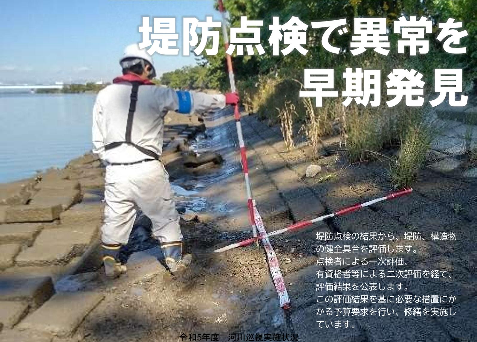
堤防点検の結果から、堤防、構造物の健全具合を評価します。点検者による一次評価、有資格者等による二次評価を経て、評価結果を公表します。この評価結果を基に必要な措置にかかる予算要求を行い、修繕を実施しています。
