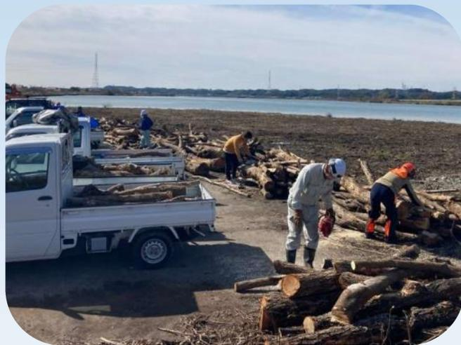
河川内に繁茂した樹木は洪水時に河川の流れを阻害したり、堤防や護岸に損傷を与えたりする可能性があるため、対策として樹木の伐開工事を行いました。
