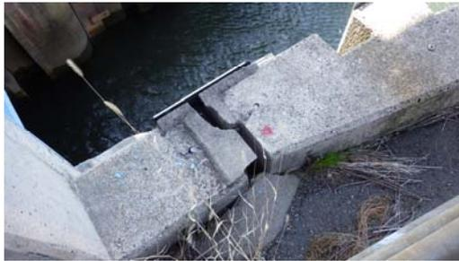
翼壁との接合部開口（長島排水ひ管）
