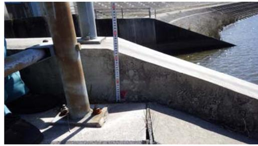
地盤（護岸）の沈下（高須輪中排水機ひ門）
