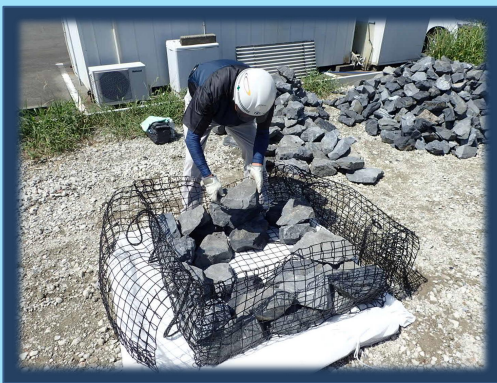
石倉カゴの作り方 (実際は河川で作業)
