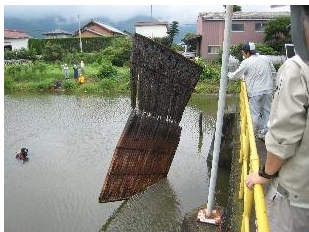
沈没船の衝突により損傷した排水機場のスクリーン (H21.7 揖斐川左岸)
