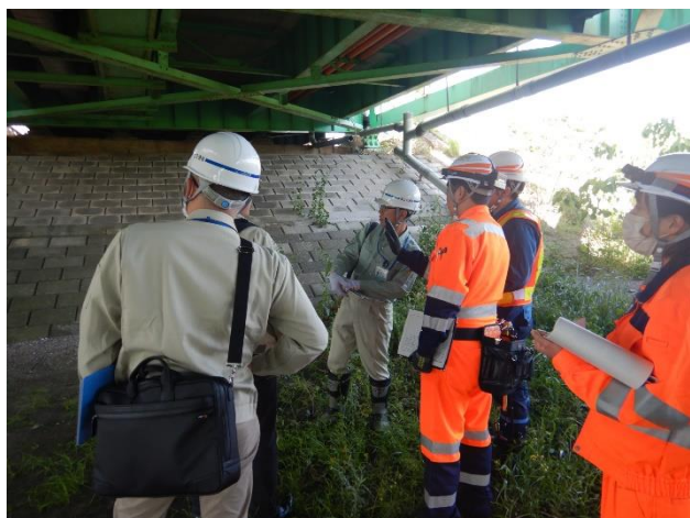
橋梁下部の点検
