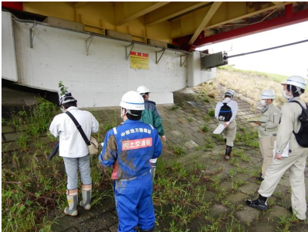
橋梁下部の点検
