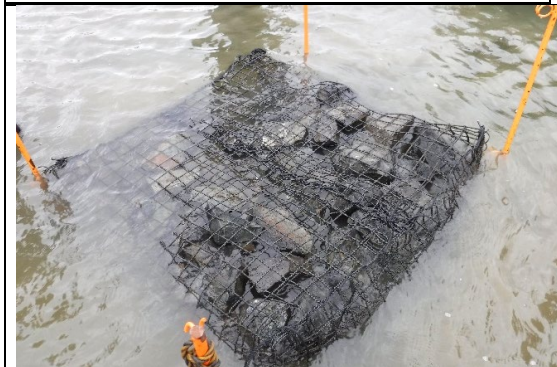
設置された石倉カゴ (津屋川)
