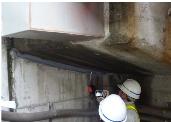
橋梁下部の点検
