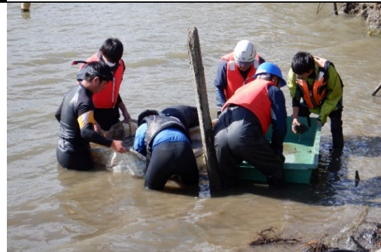
石倉カゴの引き上げ作業
