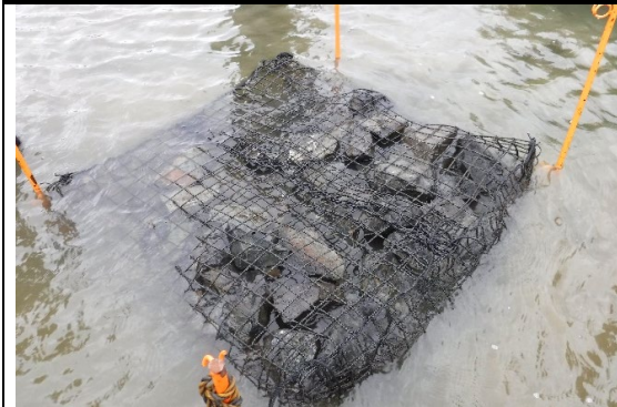
設置された石倉カゴ (津屋川)
