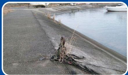
係留杭による護岸の損傷
