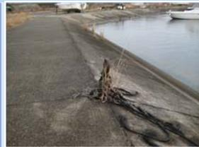
係留杭の設置による護岸損傷
