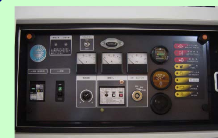
発電機操作装置
