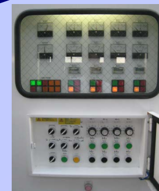
排水ポンプ等操作部
