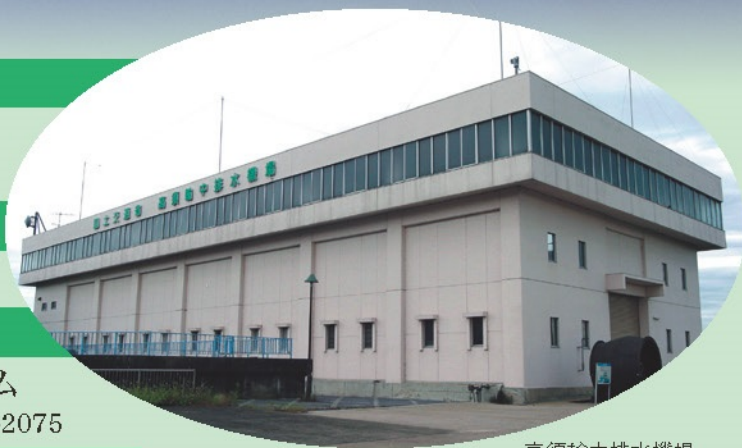
高須輪中排水機場
