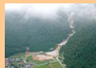
土砂を食い止める小滝砂防えん堤
