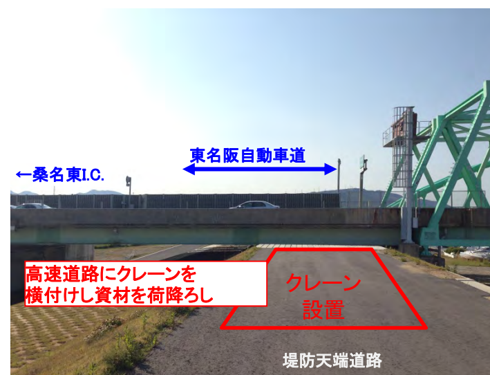
東名阪自動車と揖斐川堤防道路の立体交差部 (揖斐川右岸8.0kp付近)
