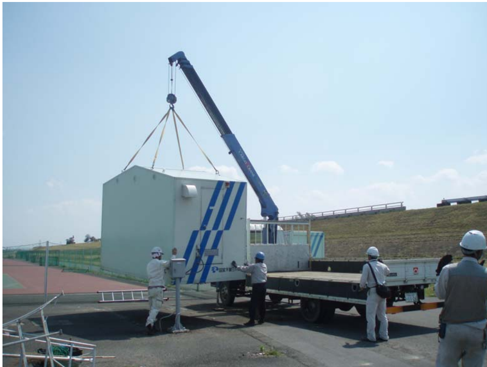
公園内のトイレをクレーンで吊り上げ、河川区域外へ搬出します
