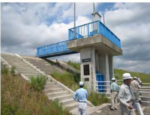
(右上) 排水機樋管出口の点検
