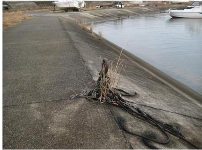
係留杭の設置による護岸損傷
