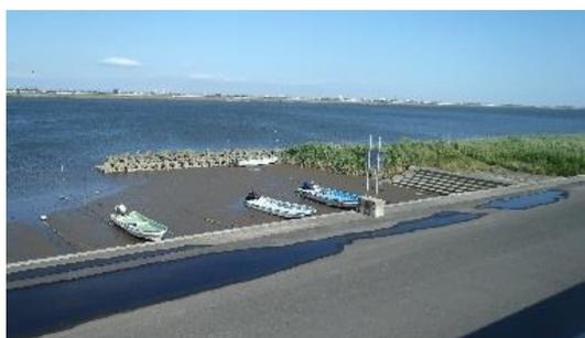
土砂堆積した変形護岸
