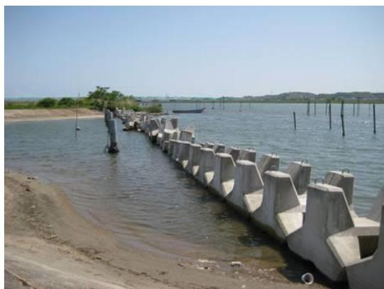
写真 13 変形護岸の締め切り（下坂手）
