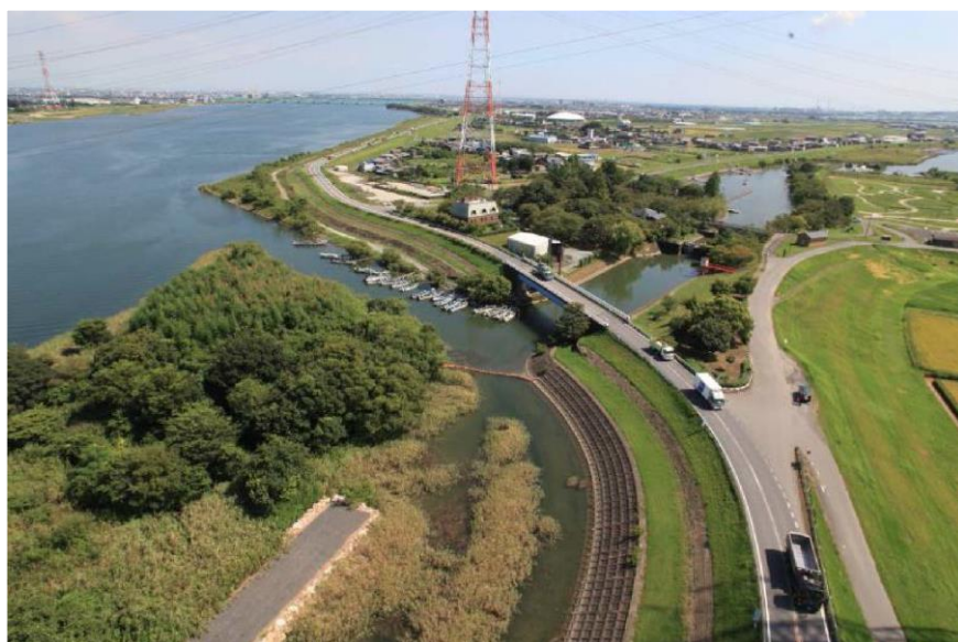
桑名市長島町西川地先から船頭平閘門木曾川水路
