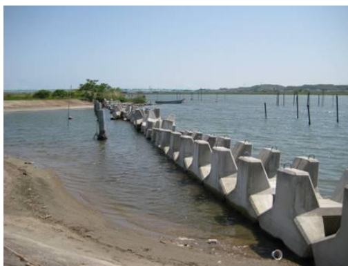
写真 12 変形護岸の締め切り(下坂手)
