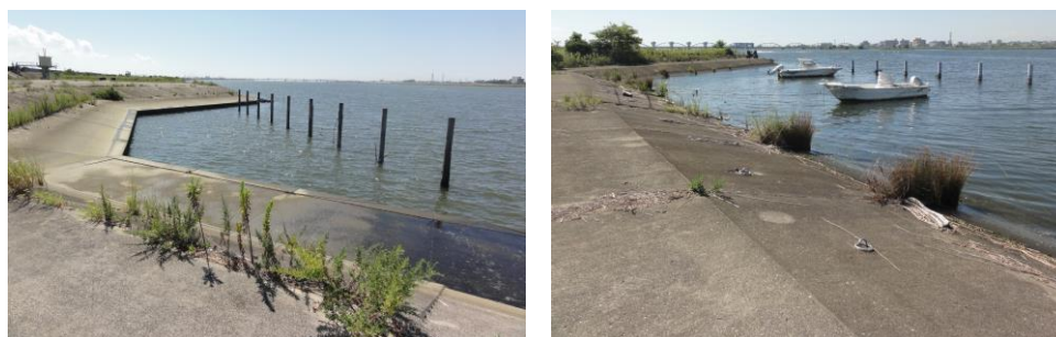
写真3 変形護岸の施設状況
