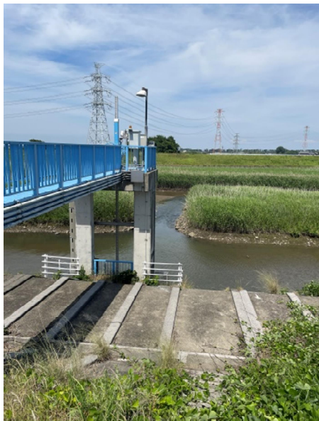
香取樋管ではポンプ場の方から川に放水してました。
