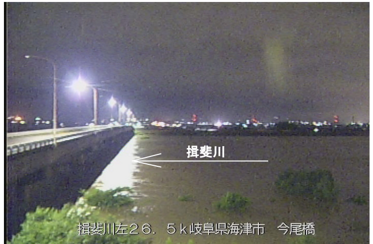
今尾橋の水位の上昇 7月7日 00:20 頃
