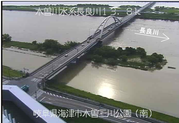
木曾三川公園の駐車場が冠水 7月8日 07:40 頃
