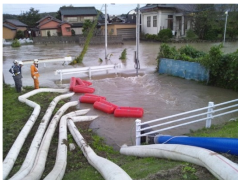
排水ポンプ車の派遣 (H29.10.23 桑名市内)
