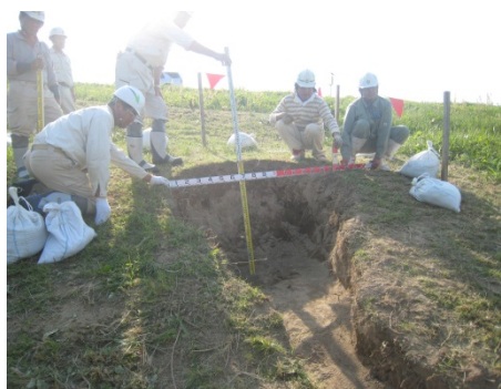
陥没の発見(詳細調査状況)
