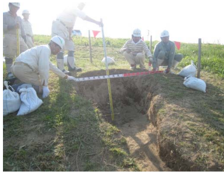
陥没の発見(詳細調査状況)
