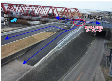
対策事例：橋梁と堤防天端間の通行対策
