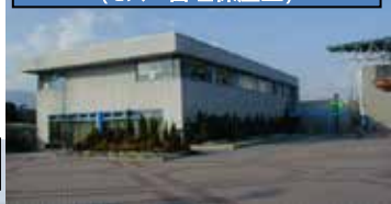
太陽光発電設備工事予定箇所 (センター管理棟屋上)
