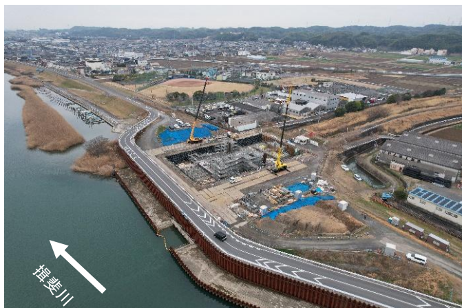
揖斐川深谷地区堤防整備事業(箇所:桑名市) 令和8年2月撮影
