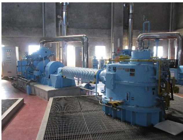
主ポンプ駆動設備分解整備
