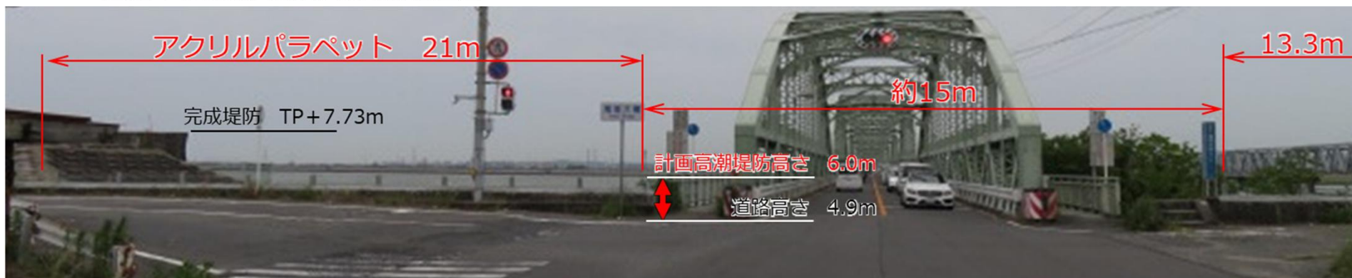
国道1号 尾張大橋 状況写真 (弥富市側)
