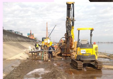
地盤改良工事
