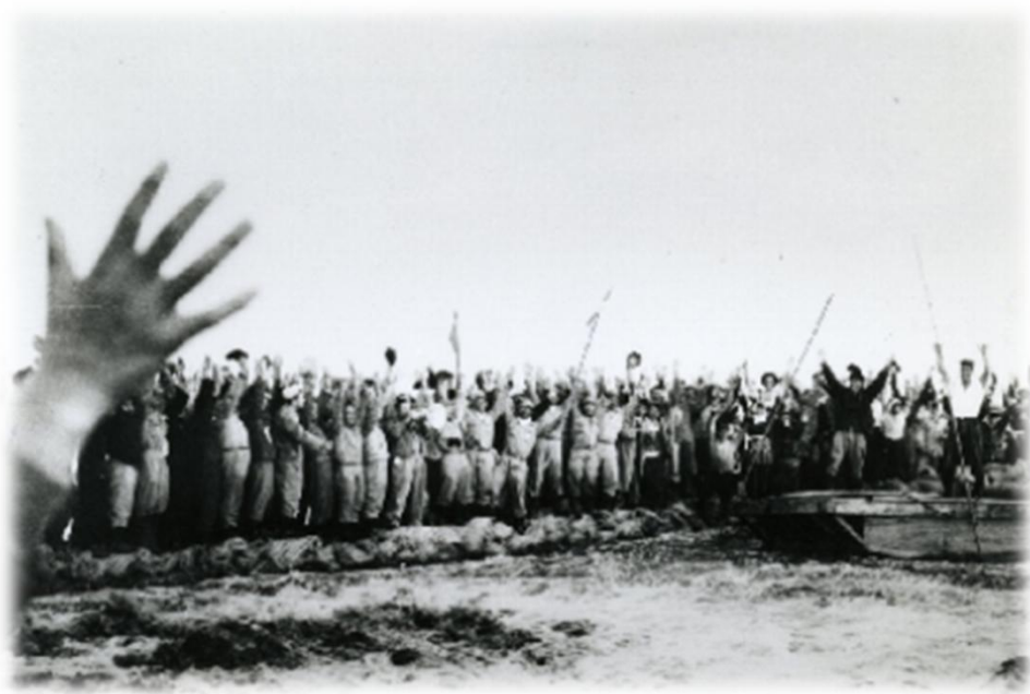
仮締切工事完了時
