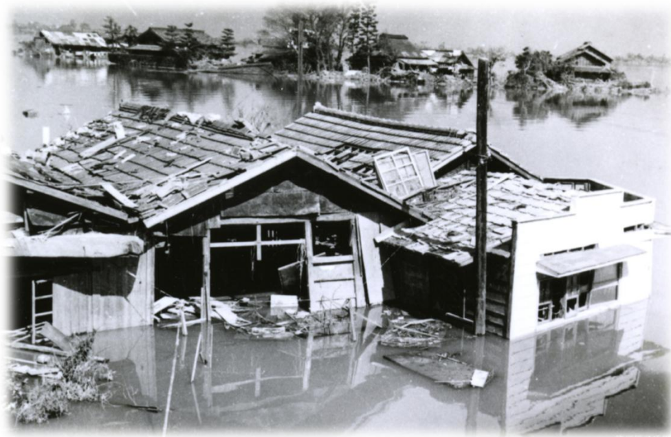
宅地浸水・倒壊
