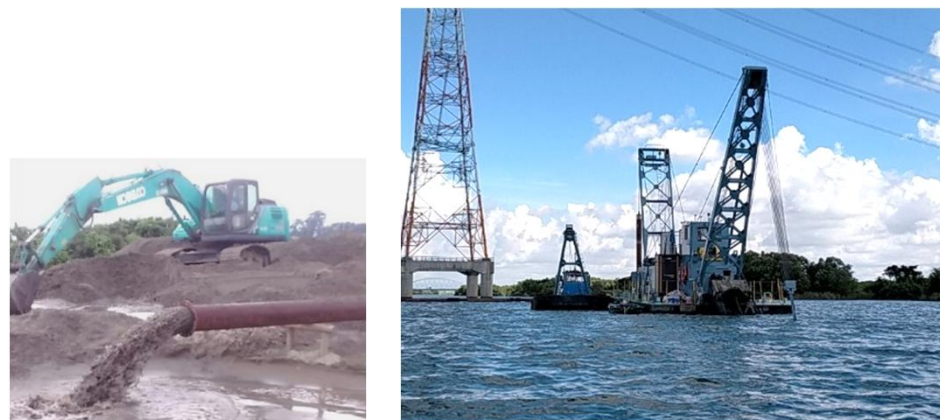
長良川背割堤(上)・福原地区しゅんせつ事業
