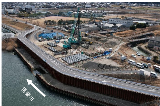
揖斐川深谷地区堤防整備事業（箇所：桑名市）
