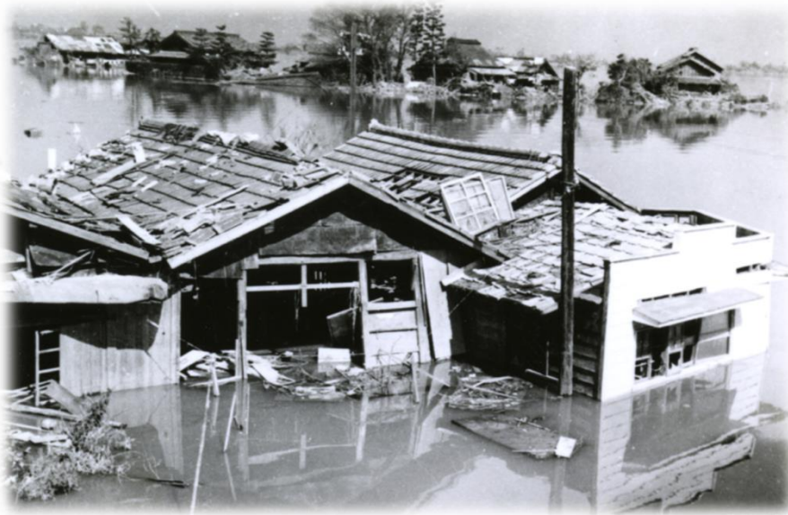
宅地浸水・倒壊
