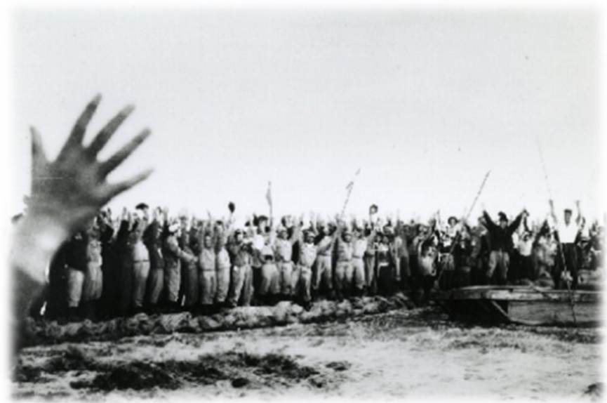
仮締切工事完了時
