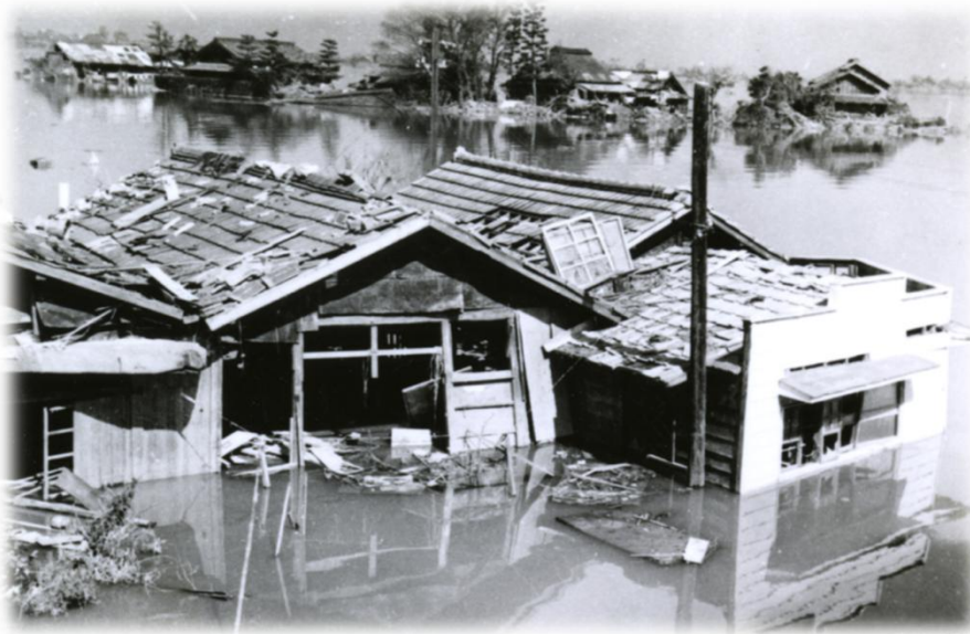
宅地浸水・倒壊
