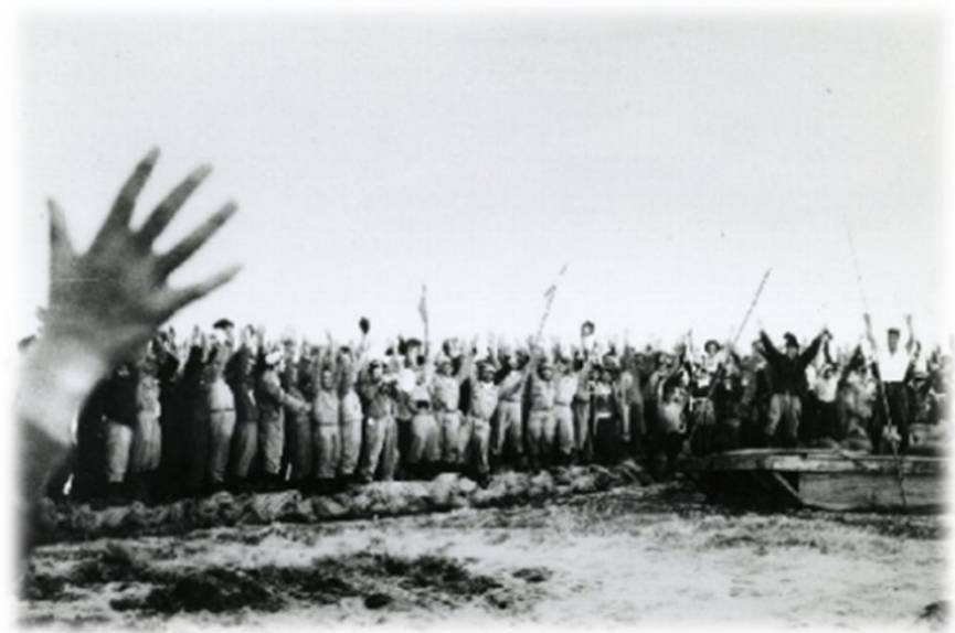
仮締切工事完了時
