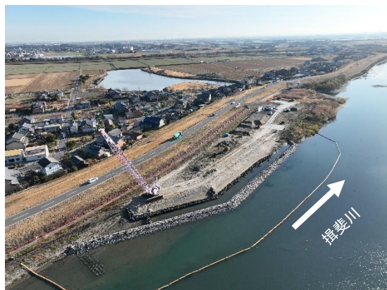
揖斐川帆引新田地区堤防整備事業（箇所：海津市）
