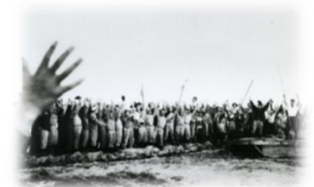
仮締切工事完了時
