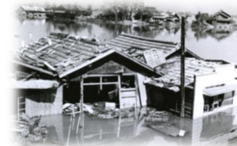
宅地浸水・倒壊
