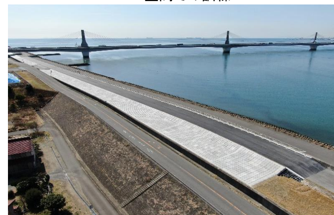
低炭素型コンクリート 施工事例
