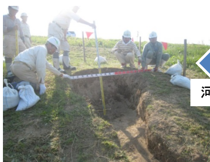
陥没の発見(詳細調査状況)
