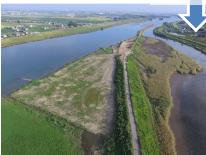
樹木の伐採状況(揖斐川22k付近)
