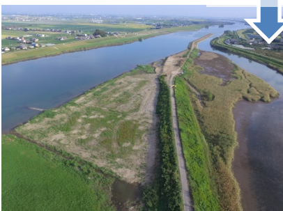
樹木の伐採状況(揖斐川22k付近)
