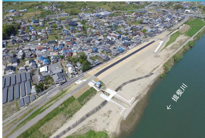
揖斐川南濃堤防整備事業
