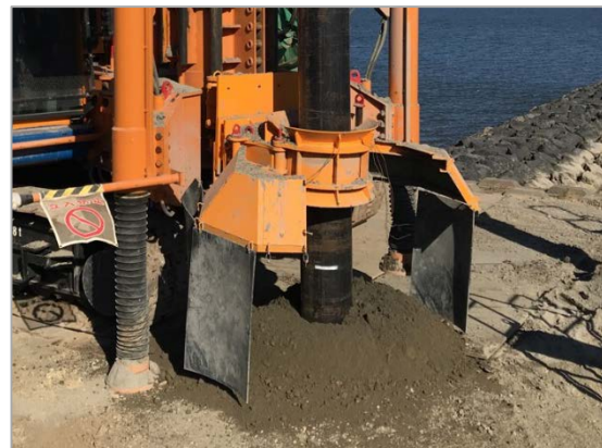
【川表】 静的締め砂杭工法 締め状況
