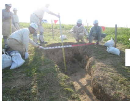
陥没の発見(詳細調査状況)
