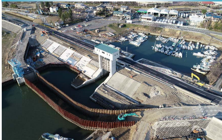
木曾川鍋田上水門改築事業
