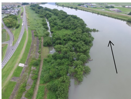
樹木の繁茂状況（揖斐川26k付近 2018. 6時点）
