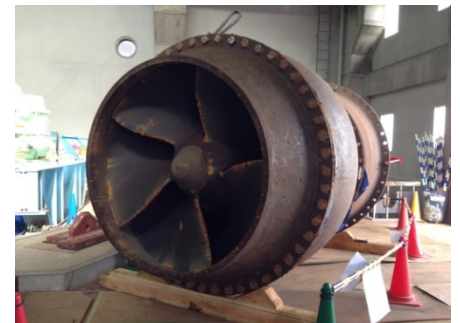
排水機場の維持管理（ポンプ修繕状況）
