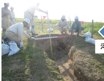
陥没の発見（詳細調査状況）
