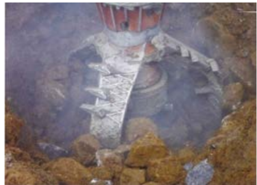
【川表】 深層混合処理工法 掘削状況
