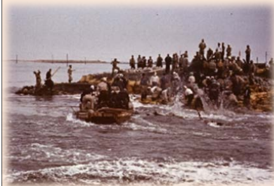
揖斐川左岸の仮締切の様子(長島町白鷺)
