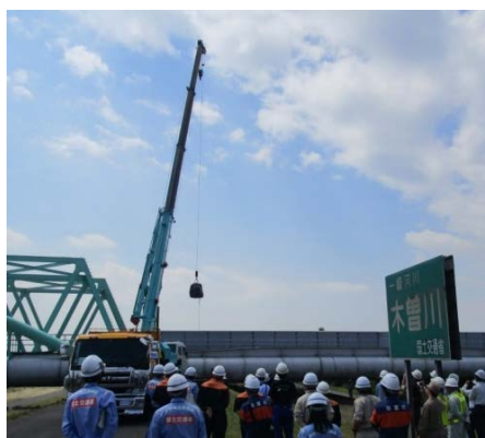
高速道路からの資材搬入訓練
