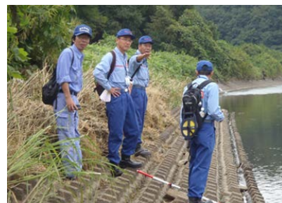
9月16日被災箇所調査状況
