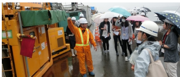
高潮堤防耐震工事の視察 (木曽川左岸 2.8kp)
