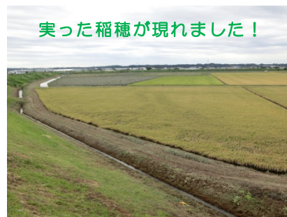
排水作業完了
