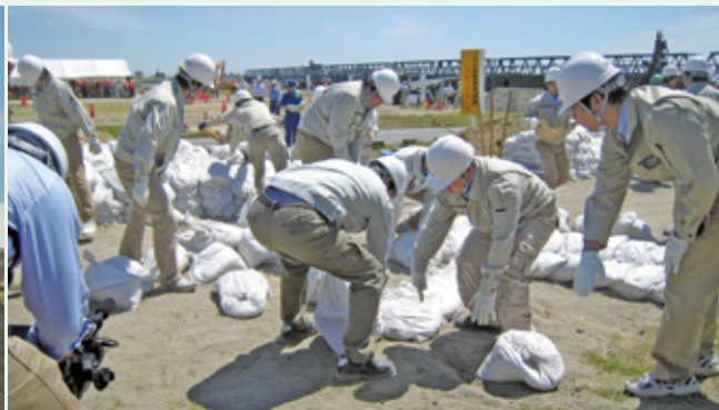
大学生による水防工法の実施
