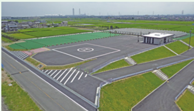
城南河川防災ステーション
