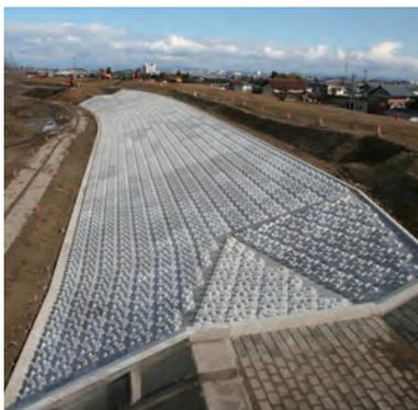
川側の護岸（コンクリートブロックを設置し土をかぶせます）
