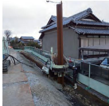
民地側の補強（矢板を地中に埋めこみ堤防を崩れにくくします）
